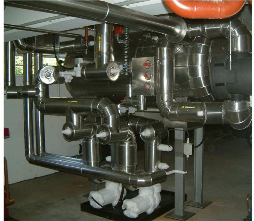
Schockfroster ca. 150 kW bei to  $-47^{\circ}\text{C}$
