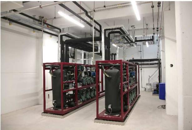
Insgesamt 11 verschiedene Anlagen mit 60 Verdichtern und 2,3 MW Nutzleistung, davon:
